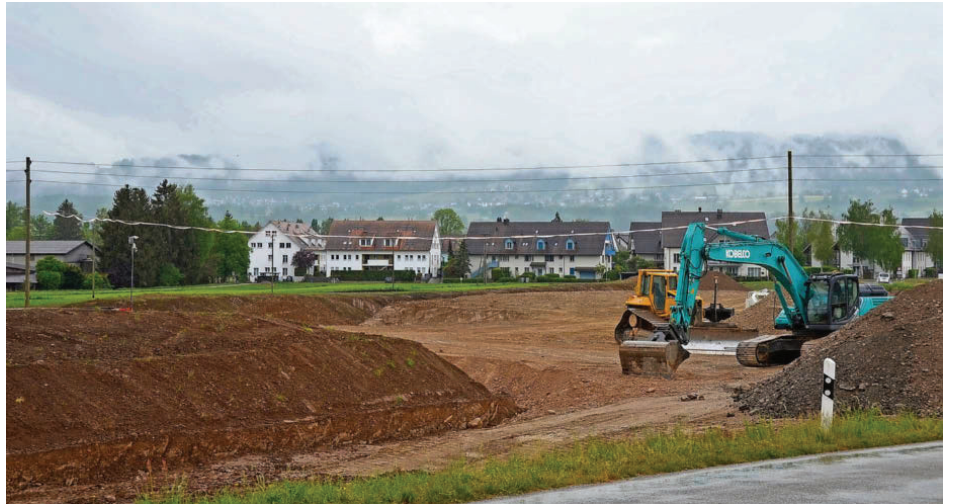
Mit Baumaschinen wird das Gelände an der Verbindungsstrasse zwischen Riedikon und Nossikon grossflächig abgetragen. Foto: Martin Mächler
